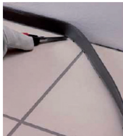
Saumauksen valmistuttua leikkaa pois ylimääräinen Mapesonic Strip-irrotuskaista.
