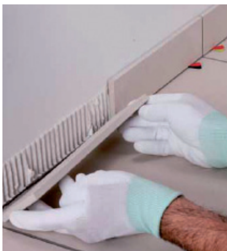
Asenna jalkalista siten, ettei se kosketa lattiapäällystettä.
