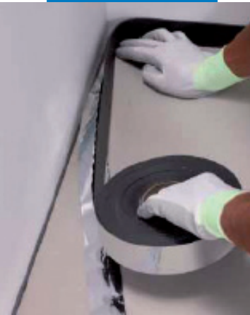
Asenna Mapesonic Strip ympäröivän tilan pystypinnoille.
